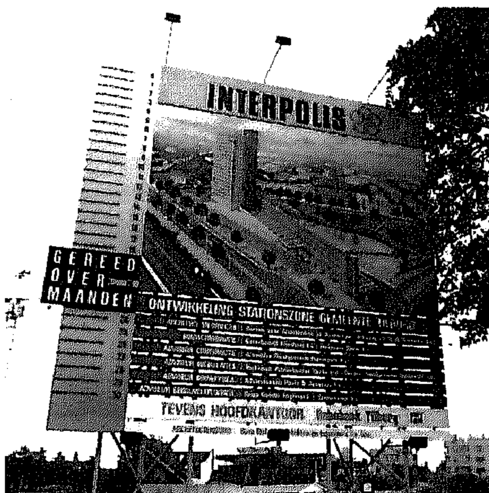
Architectuur op de vrije markt: Interpolis in aanbouw
